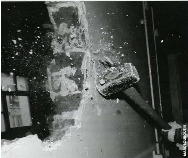
TRAVAUX AU 100, RUE DE CHARENTON
