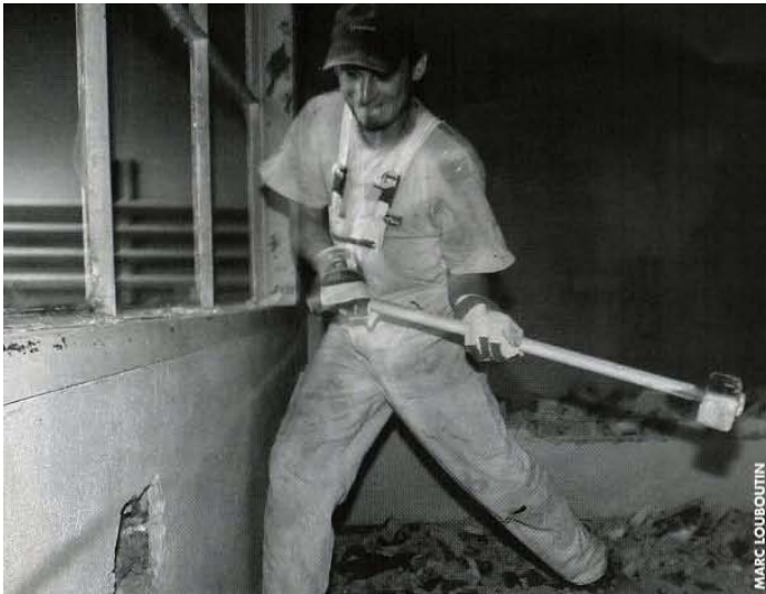
TRAVAUX AU 100, RUE DE CHARENTON
